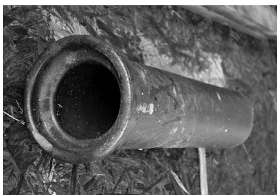
↑土管を切断して使用している
