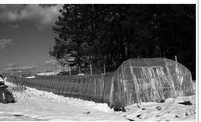
雪の重みに耐えきれず倒壊したハウス
