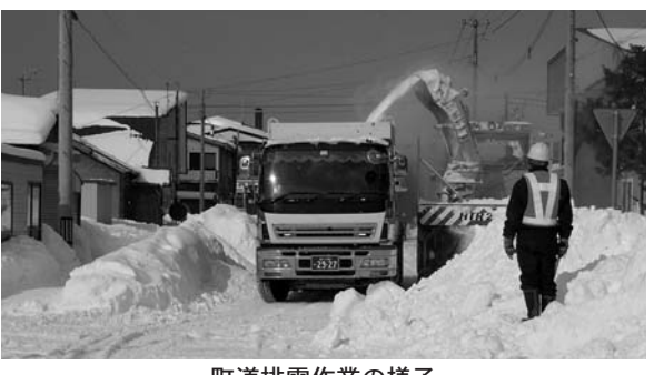
町道排雪作業の様子
