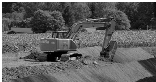
道管中山間地域総合整備事業 除れき作業(金山地区)
