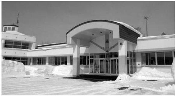
屋上防水補修などが予定されている北落合小学校校舎
