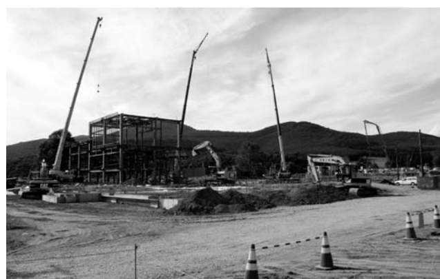
12月の完成に向けて工事が進められている工場建設現場
