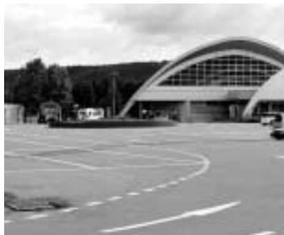
きれいに整備された道の駅駐車場
