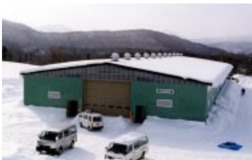
供用が開始される一般廃棄物最終処分場
